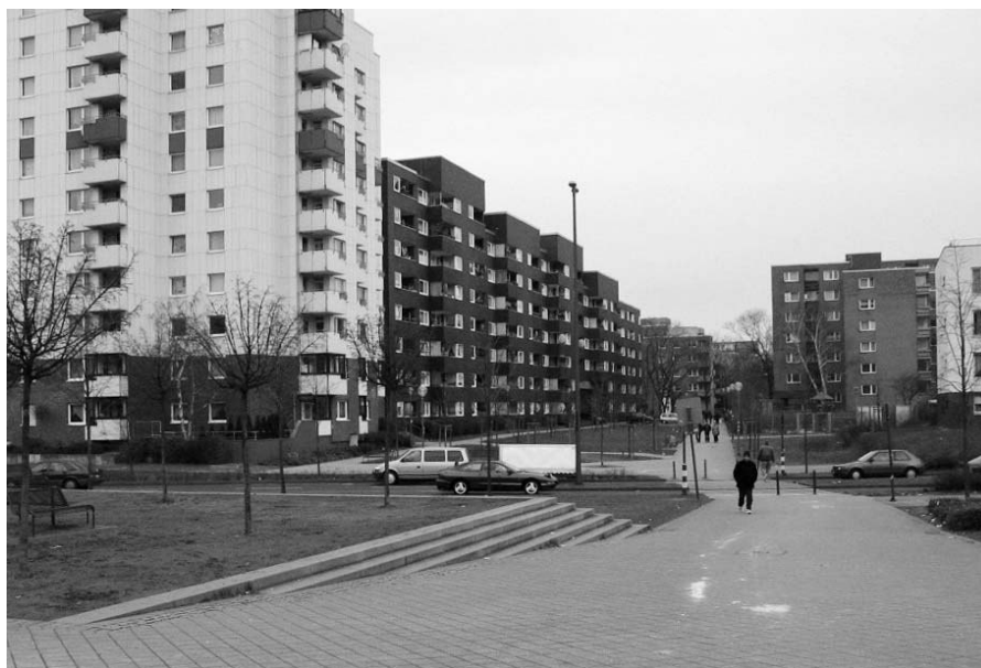
Viele der Hochhäuser im Kölner Stadtteil Chorweiler sind stark sanierungsbedürftig. In einigen leben drei Viertel der Bewohnerinnen und Bewohner von staatlichen Transferleistungen. Immer weniger Menschen beteiligen sich dort an Wahlen.
